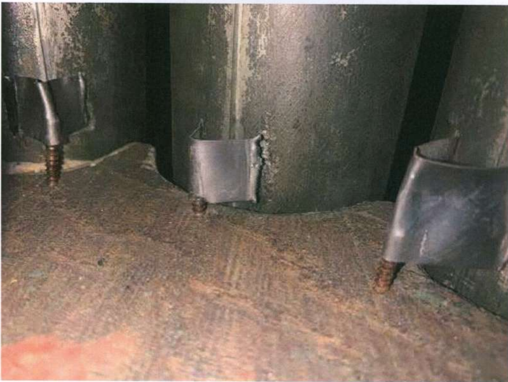
Attache dessoudée et autres attaches abîmées
