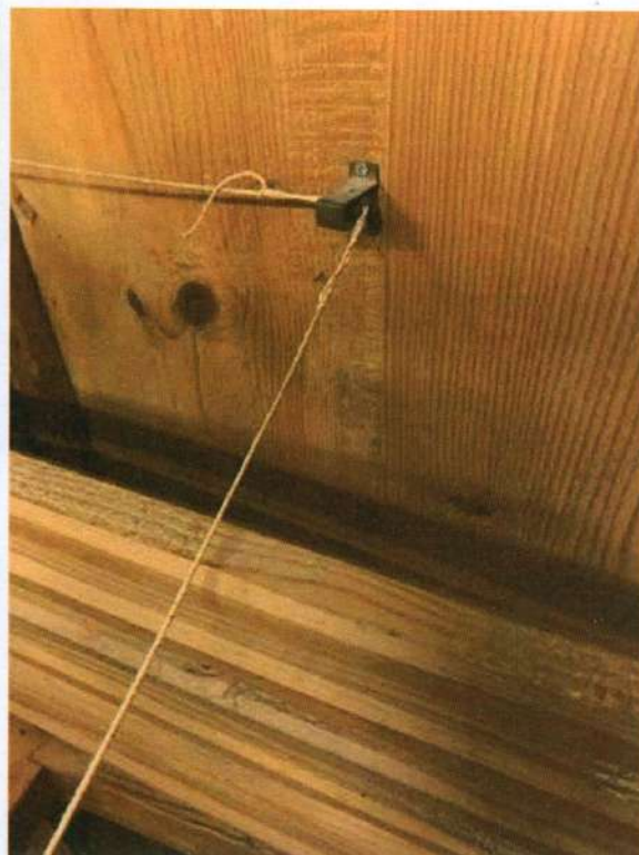
Le rossignol dans sa position actuelle et le système de mise en route qui s'use dans l'angle et a déjà cassé
