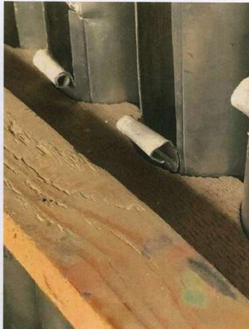
Attaches de la façade et enroulage impropre de la patte d'accord qui pourrait être droite
