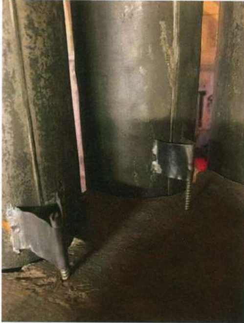
Attaches de la façade et enroulage impropre de la patte d'accord qui pourrait être droite
